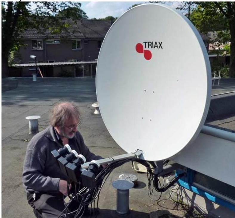
Foto 6: de werkzaamheden op het dak. De schotel is vervangen door een groter formaat. Sjaco is druk en geconcentreerd bezig met het ontwarren van de kabels en die op de juiste uitgangen van de Lnb-'s aan te sluiten. Iedere kabel heeft zijn vaste plek; Horizontaal Laag: Horizontaal Hoog, Verticaal Laag en Verticaal hoog en dat alles vier keer voor de vier satellieten. Eén kleine vergissing en alles moet opnieuw nagemeten en gecorrigeerd worden. Dus, het 'koppie erbij' houden.
