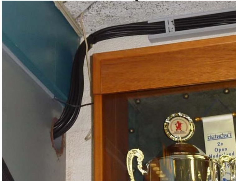
Foto 5: de doorvoer van de kabels vanuit de zaal gezien naar de multiswitch in de hal.
