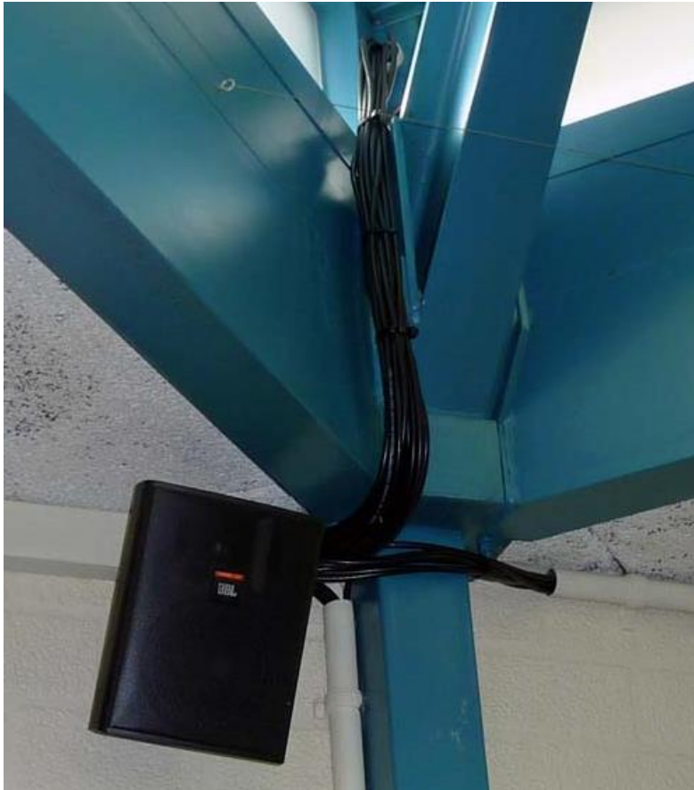
Foto 12: detail van de kabels en de doorvoeren naar het dak.
